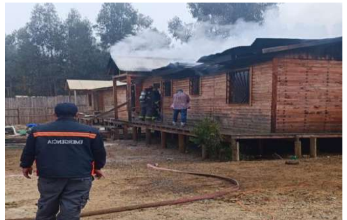
Incendio estructural, El Michay, 20 de abril 2022
