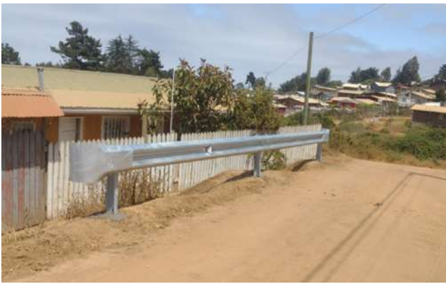
Defensa en Quebrada Paso Cordillera, El Tabo. 2 tramos
