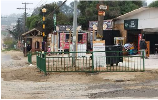
Vallas peatonales tipo Conaset (20 metros), los cuales fueron instalados en la Ruta G-98 con camino vecinal Chépica.
