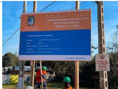
"Construcción Alcantarillado Sector San Carlos, comuna El Tabo"
