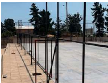
Construcción Multicancha Piedra del Elefante, El Tabo
