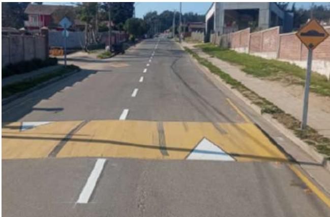
Calle Miraflores - El Tabo (1 unidad de 10 metros).
