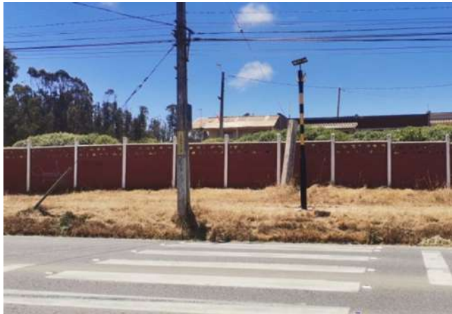
Balizas peatonales solares (2 unidades) Ruta G98F Los Cisnes (Escuela Especial Nadiel).
