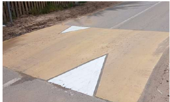
Camino vecinal Chépica - El Tabo (1 unidad de 6 metros)
