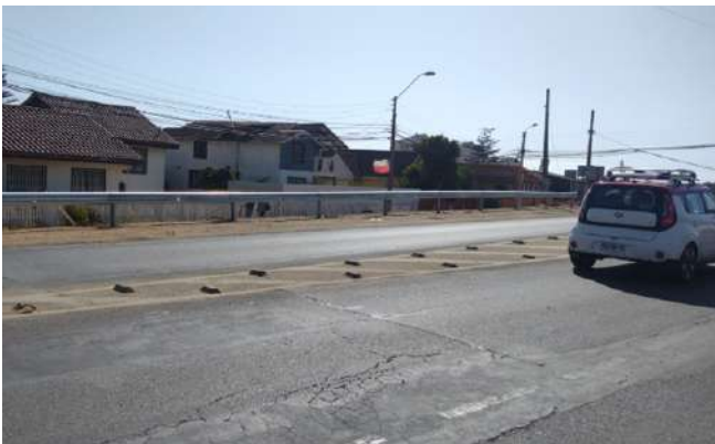
Defensa Caminera en Ruta G-98, Sector Monolito, El Tabo. 12 tramos
