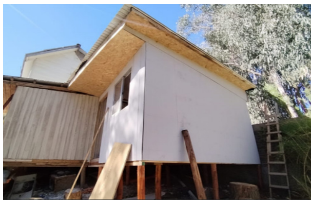
Ampliación de vivienda.
