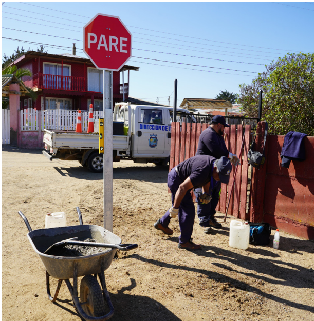
Funcionarios municipales instalando señalética en la vía pública.
