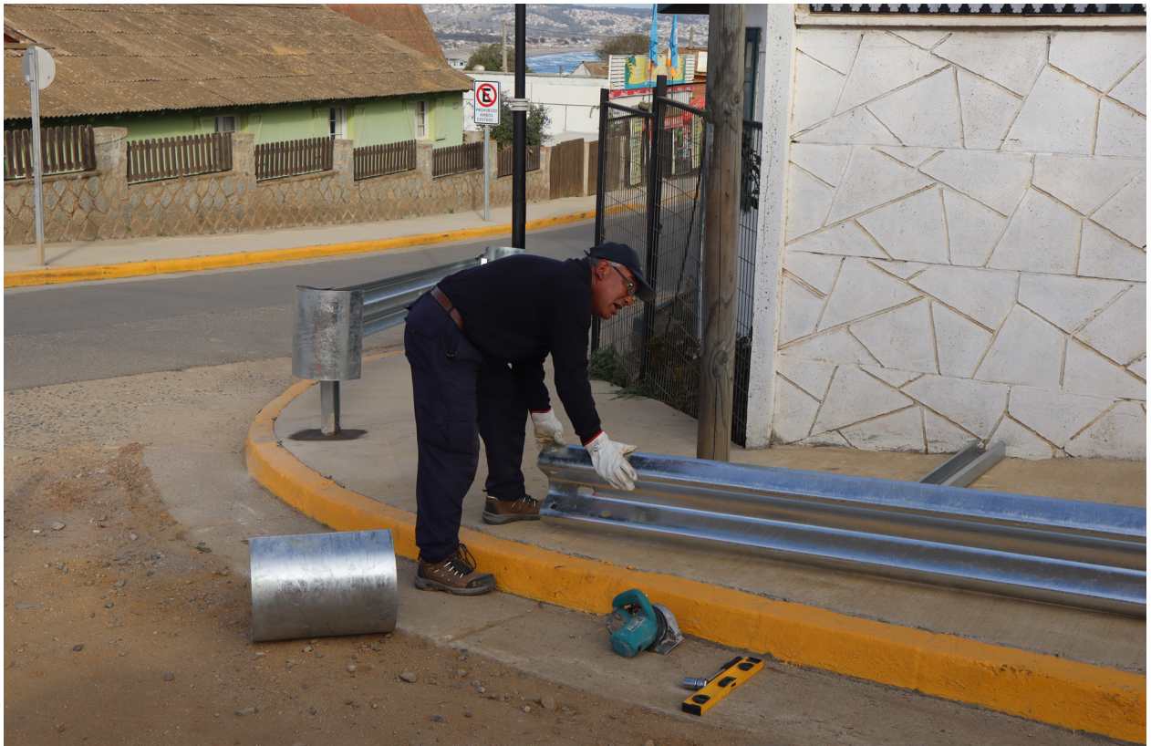
Funcionario municipal instalando barrera de protección en una calle.
