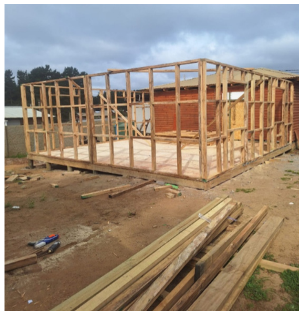
Esqueleto de ampliación de vivienda.
