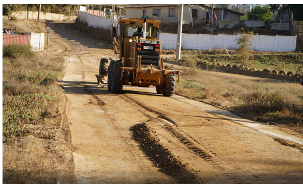
Máquina efectuando reparación de calle en zona rural.
