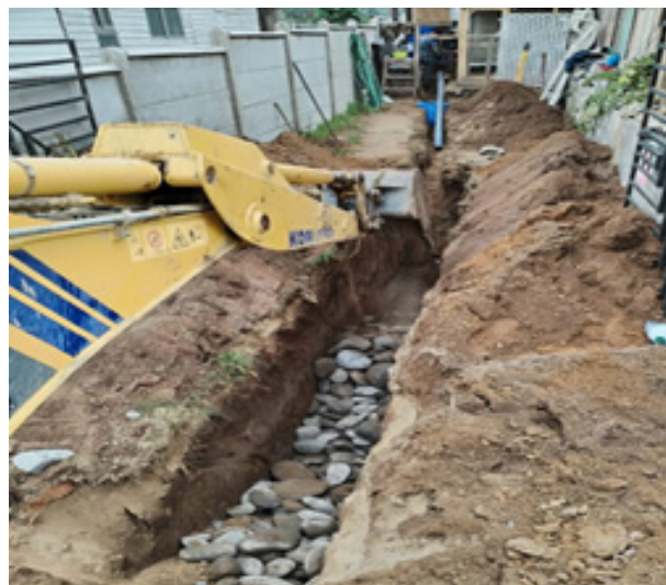
Maquina trabajando en sistema de alcantarillado particular.
