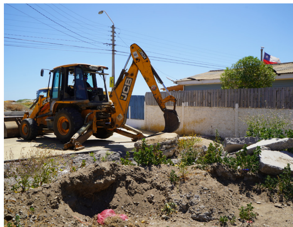
Maquina efectuando movimiento de tierra y escombros.
