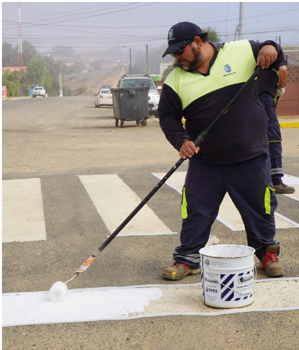
Funcionario efectuando demarcación de paso de cebra.
